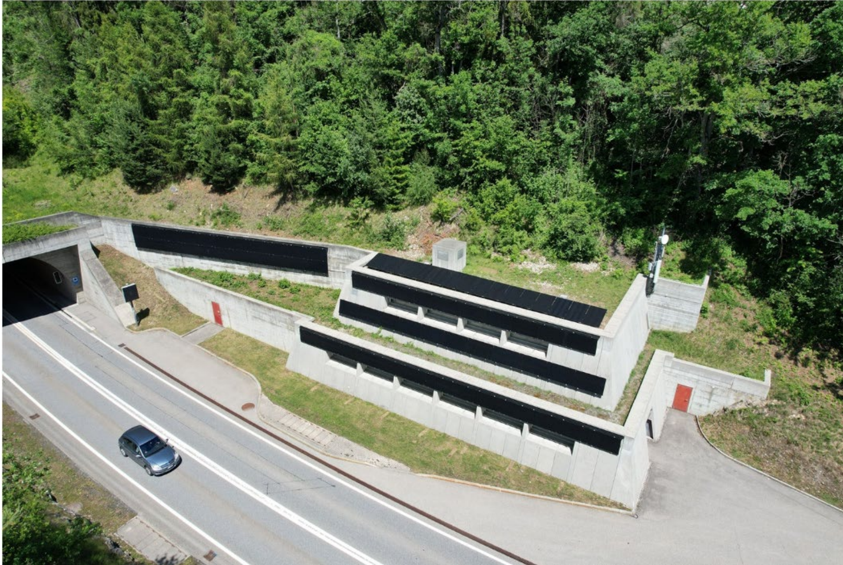
Tunnelportal Trin (Tiefbauamt Graubünden)
